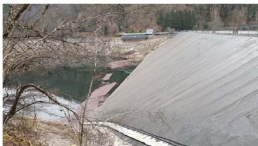
Vue du nouveau parement bitumineux du barrage. La partie superficielle inférieure ne présente pas les garanties d'étanchéité attendues. Photo DNA /Grégoire GAUCHET
