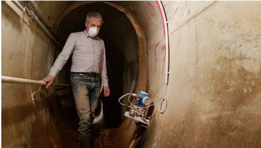
Georges Walter, directeur de l'environnement et du cadre de vie au département du Haut-Rhin. Au cœur du barrage, une galerie de drainage évacue les eaux de source captées et celles des drains. Deux fois par jour, un garde-barrage vient y relever les différents paramètres de mesure. Ceux-ci sont également transmis en continu par ordinateur. Photo DNA /Grégoire GAUCHET
